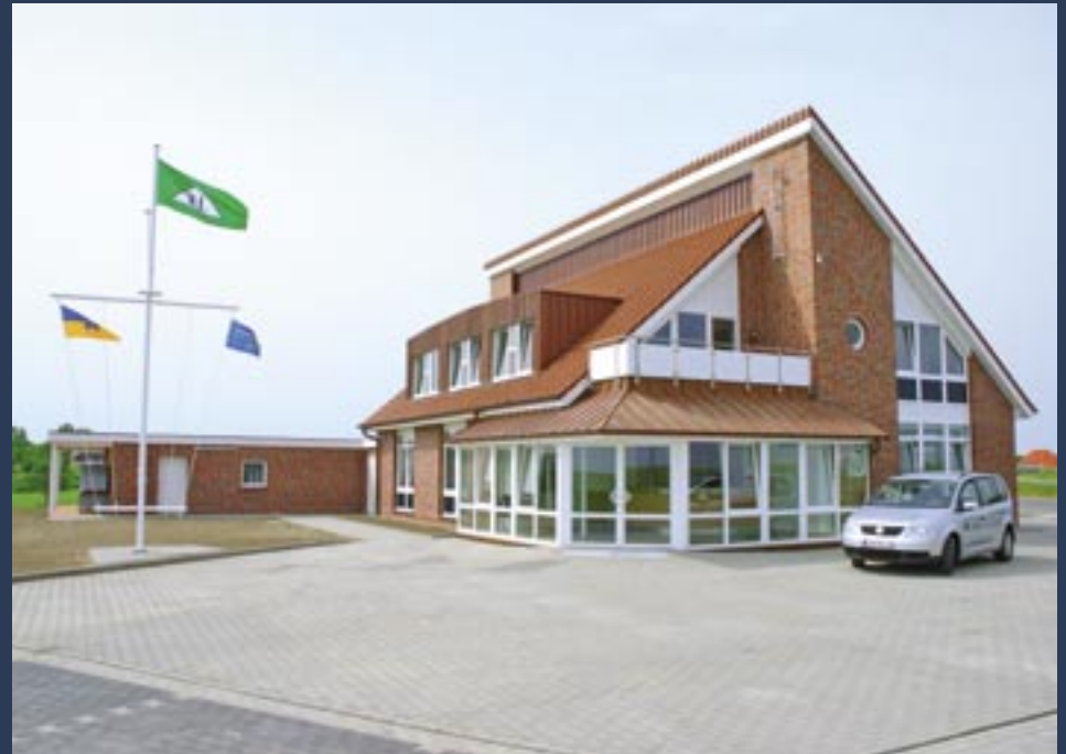
Neues Informations- und Verwaltungsgebäude seit Juni 2008
