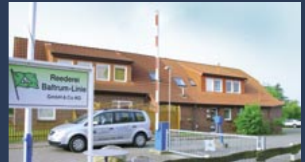
Betriebsstätte Neßmersiel seit 1938 bis heute, Dorfstraße 45 in Neßmersiel
