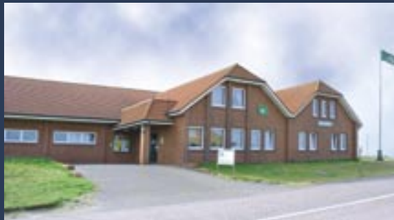
Seit 1986 Betriebsgebäude mit Lagerhalle, Haus Nr. 278 auf Baltrum
